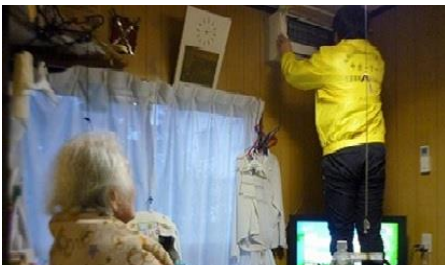
高齢者宅でエアコンの点検
